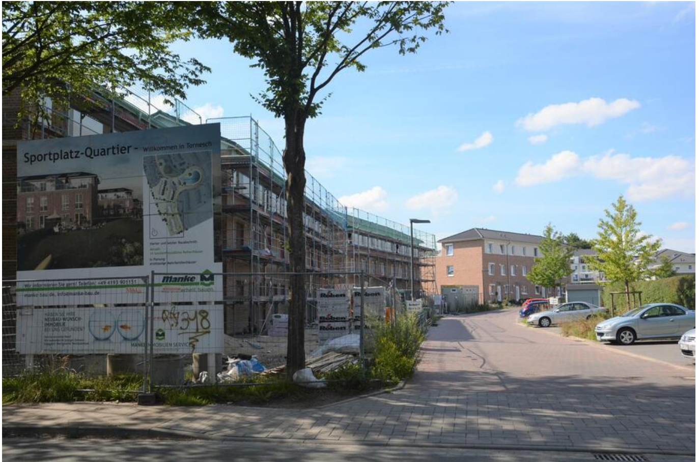
Das Neubaugebiet „Alter Sportplatz“/Friedlandstraße bietet mit 130 Wohneinheiten in Reihen- und Mehrfamilienhäusern zentrales Wohnen für Jung und Alt. Gerade entstehen die letzten Reihenhäuser. Foto: HassPR
