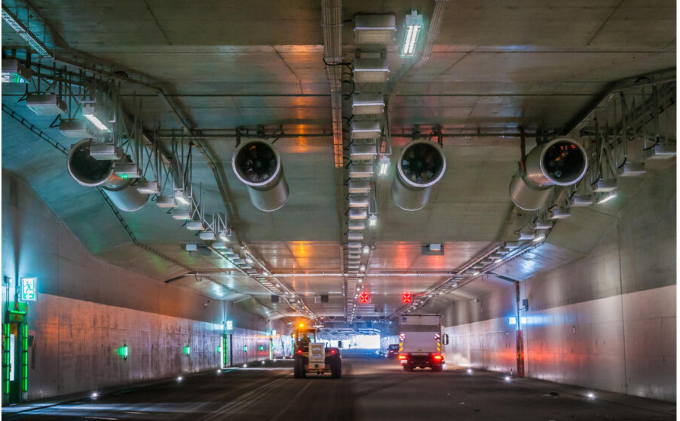
„Hamburger Deckel“ - Mehr als 120 Strahlventilatoren, unter anderen vom Typ Banana Jet, umfasst der Auftrag für die Firma Witt, die Tunnel im Zuge des A 7 – Ausbaus von Schnelsen bis Altona mit Ventilatoren auszustatten. Foto: Witt
